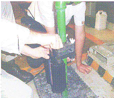
Sujeción del transductor a tubería sin adaptaciones especiales o cortes en el tubo
