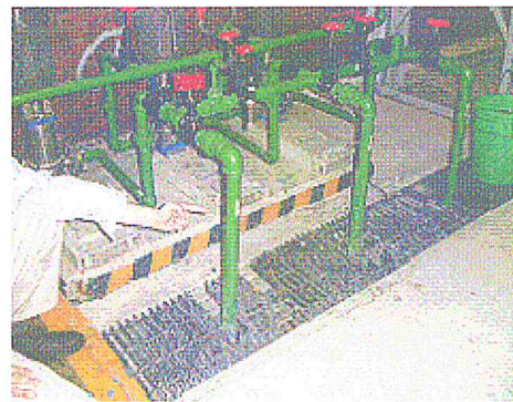
Punto de instalación del equipo sin cortes en tubería
